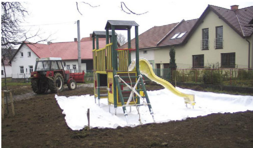
Prolézačky v Počítkách vybudované za podpory MMR
